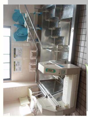
一般棟の入浴補助設備「スロープエース」。専用の車いすに座ったまま入浴できます。
